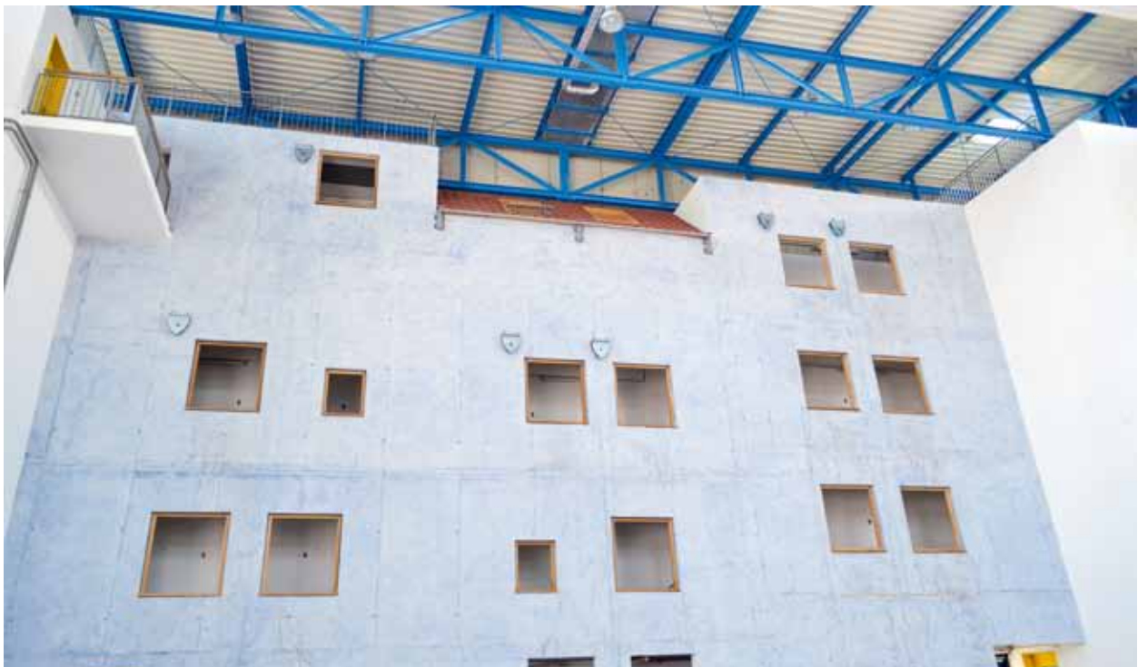
Foto 7 – Clădire machetă P+3 pentru antrenament atât la stingerea incendiilor, cât și pentru executarea acțiunilor de salvare cu scările de fereastră
